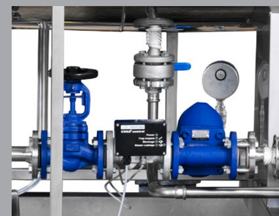
Entwässerungsgruppe mit Überwachungseinheit
